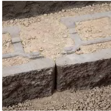
Diagram 5 - Core Fill
